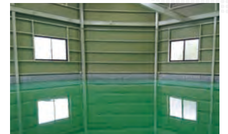
創業4年目を前に甲賀市に新工場を建設した。主に組み立て作業などを行う。
