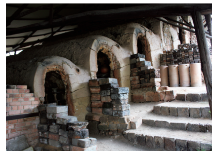
▲登り窯は山の斜面に、小さな焼成室をいくつも連ねた形の窯。信楽では昭和初期頃まで火鉢や茶釜が焼かれていた。焼かれた後のススが今でも壁に残っている。
