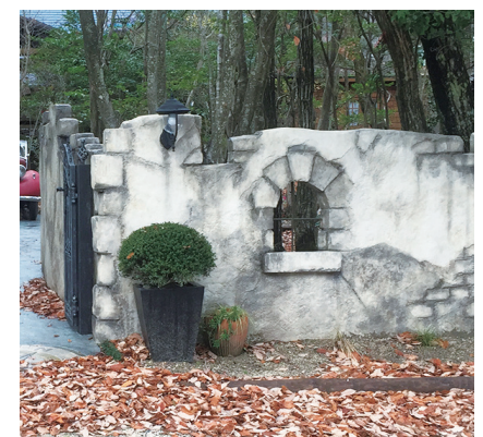
▲建築用発泡スチロールとモルタルで作られた外塀。発泡スチロールは加工しやすいため、複雑なデザインが可能。
