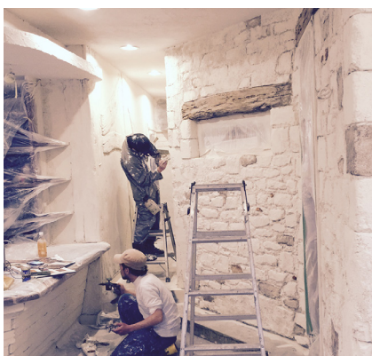
▲アトリエの改裝作業。もともとある壁やカウンターにモルタルでレンガや木材の形を作っていく。モルタルと塗装を組み合わせれば、表現できないものはほとんどない。自由な発想力で、オンリーワンの空間になる。
