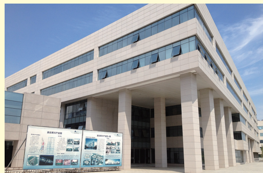
▲初の海外拠点として2012年に設立した中国現地法人の入居するビル(天津市)
