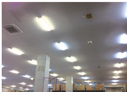
▲倉庫の設置例 改修前 改修後 照明器具の台数200台→72台、平均照度345lx→377lx、年間使用電力63,360kWh→23,587kWh、年間電力料金1,077,120円→400,979円、CO 2 排出量32,567kg→12,124kg 照度はアップしコスト削減率は63%と具体的効果をみせている
