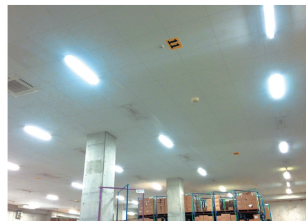
▲倉庫の設置例 改修前 改修後 照明器具の台数200台→72台、平均照度345lx→377lx、年間使用電力63,360kWh→23,587kWh、年間電力料金1,077,120円→400,979円、CO 2 排出量32,567kg→12,124kg 照度はアップしコスト削減率は63%と具体的効果をみせている
