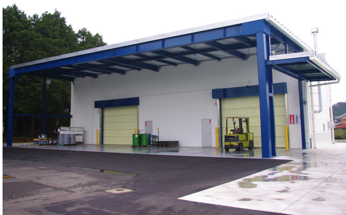
▲ 2012年11月に増設した新工場。独自の省力機械やコンプライアンス対応、空調も取り入れ、従業員の作業環境を格段に向上させた。
