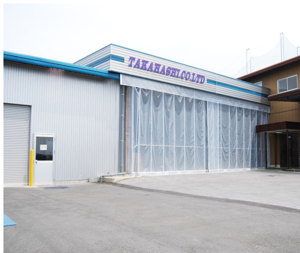
▲加工から組立までの一貫生産を行う生産拠点、多賀工場の外観。
