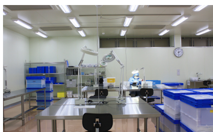
▲クラス 10000(アメリカ連邦規格 Fed Std. 209D に適合したクリーンルーム。室温 23℃、湿度 50% に保たれている。
