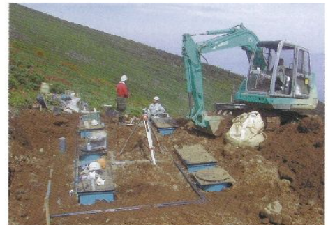
実験的に行われた、汚泥処理システム工事(ハヶ岳連峰)
